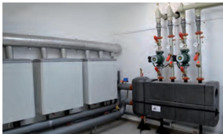
Рис.2 Крышная котельная ресторана, 360 кВт
