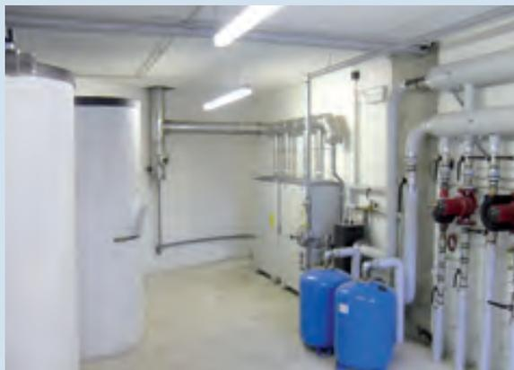
Система отопления была спроектированная для небольшого многоквартирного дома на 22 квартиры. Котельная включает в себя 2 Combidens по 90 кВт, 2 бойлера по 1000 л. каждый и 6 солнечных коллекторов, установленных на крыше котельной. Солнечные коллектора были установлены с целью уменьшения потребления газа при производстве ГВС.
