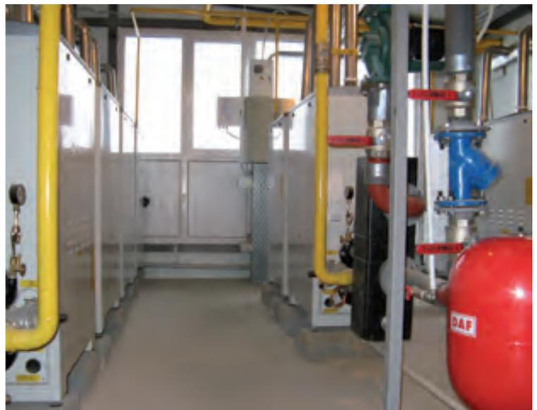
*Рис. 6 Крышная котельная гостиничного комплекса*
